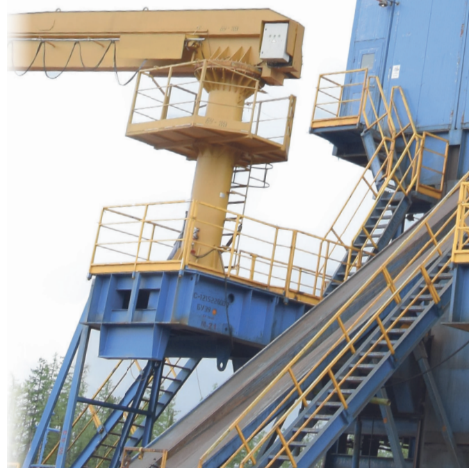
Буровая установка на КП-53
